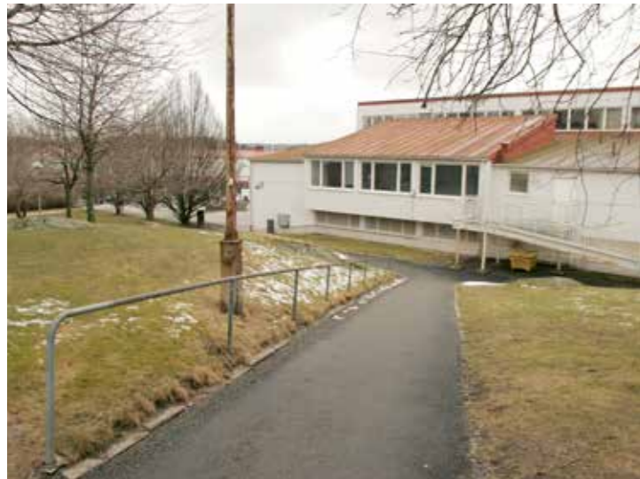
6. Gångväg mellan Bilradiogatan och torget som binder samman bostadsområdet med Torget. Forumbyggnaden sedd från norr.
