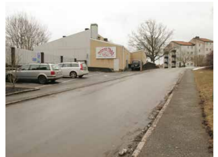
5. Charkuterifabriken med del av parkeringshuset synligt till vänster, vy längs Bildradiogatan söderut. Bebyggelsen i området väster om torget utgörs nästan uteslutande av grupperingar av bostadsbebyggelse med enhetligt utförande. Parkeringshuset och charkuterifabriken avviker därmed från bebyggelsen i övrigt.
